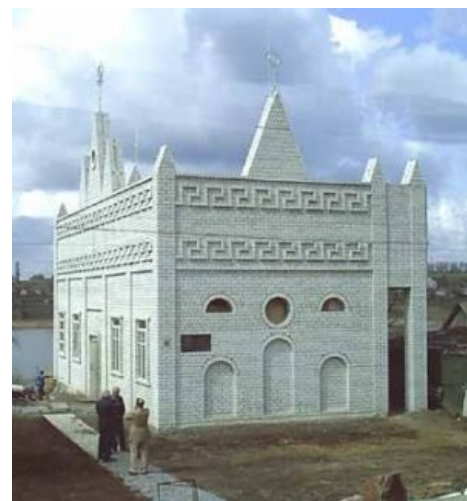
Трансформаторная будка Святыня РУНВіри
