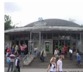
Горьковская до реконструкции (с подпорками!)
