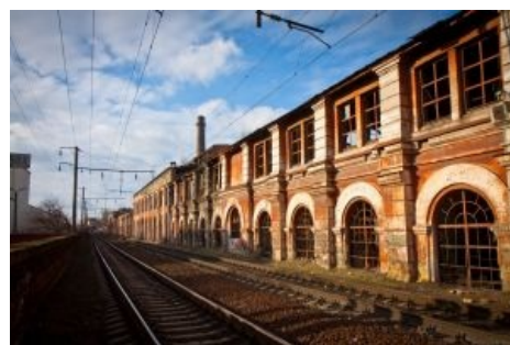
Руины завода «Краян». До вокзала осталось 5 минут.
